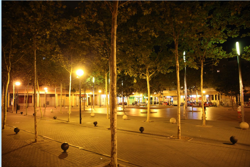
Luminarias vapor de sodio
